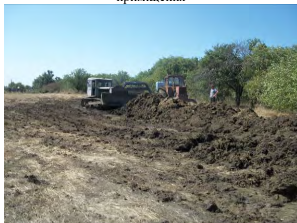
г) Укрупнення буртів бульдозерним обладнанням
