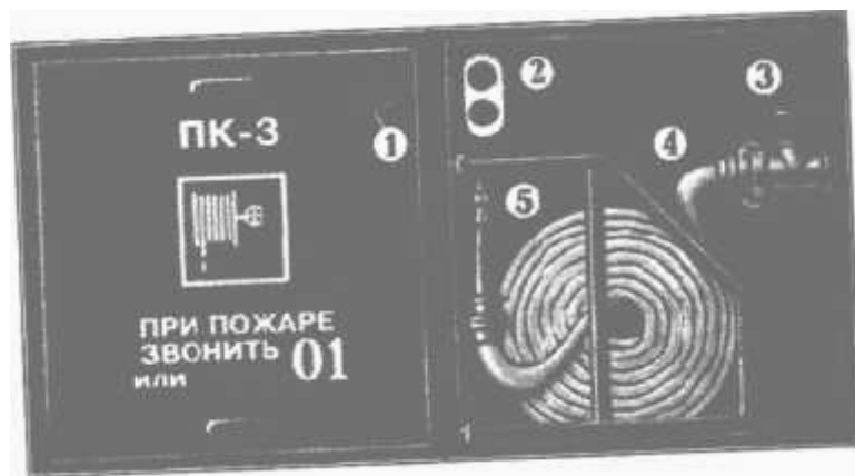
Рис. Внутрішній пожежний кран:
