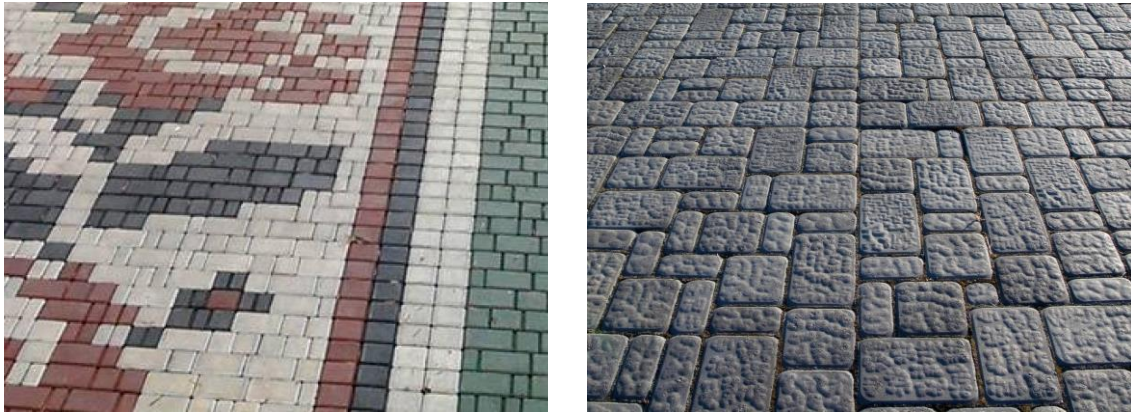
Рисунок 3 – Приклади влаштування тротуарів з фігурних бетонних виробів
