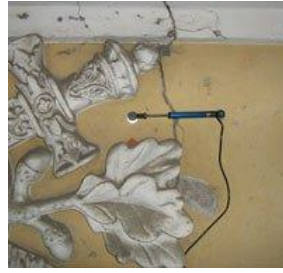
Рисунок 6 - Датчики розкриття тріщин і стиків конструкцій
