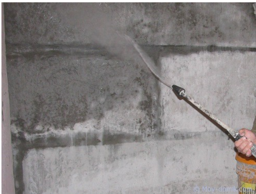
Рисунок 1 – Покриття стін порошкоподібною субстанцією
