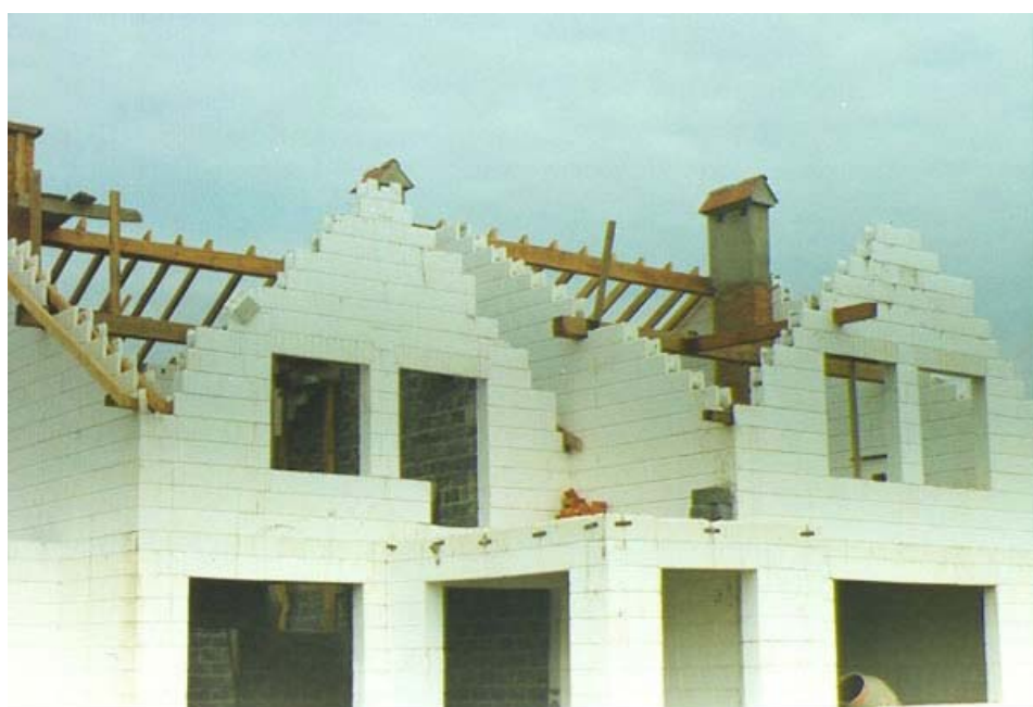
Рисунок 1 – Незйомний опалубок “Теплий дім”
