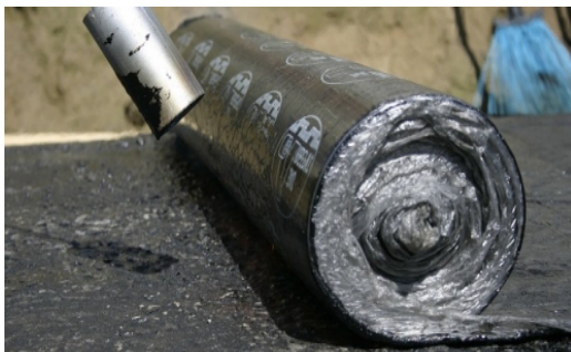
Рисунок 2 – Приклад виконання обклеювальної гідроізоляції.
