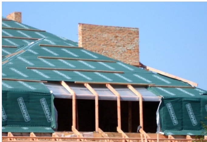
Рисунок 9 – Приклад виконання мембранної гідроізоляції.
