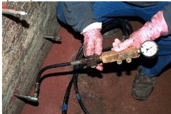
Рисунок 8 – Приклад виконання ін'єкційної гідроізоляції.
