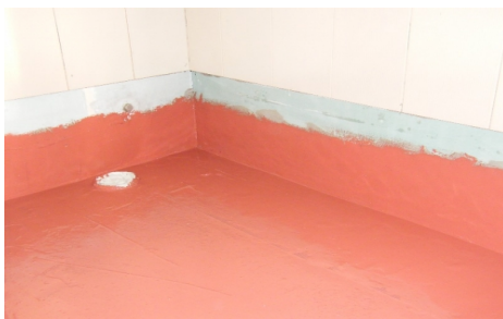
Рисунок 3 – Приклад виконання фарбувальної гідроізоляції.
