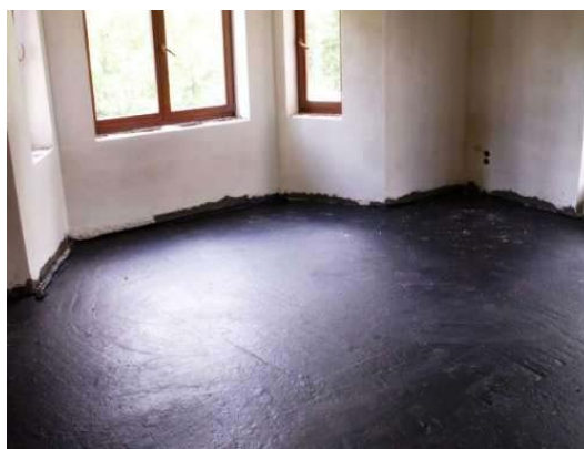
Рисунок 1 – Приклад виконання обмазувальної гідроізоляції.
