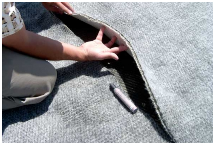
Рисунок 10 – Приклад укладання бентонітових матів.
