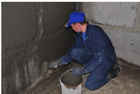
Рисунок 6 – Приклад нанесення проникаючої гідроізоляції.
