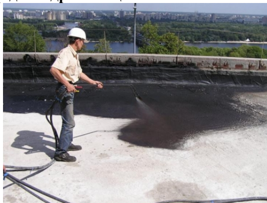
Рисунок 4 – Приклад виконання напилювальної гідроізоляції.
