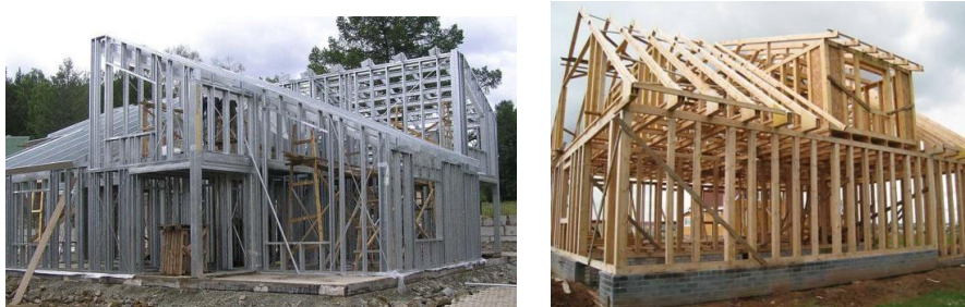
Рисунок 1 – Технологія каркасного будівництва.
