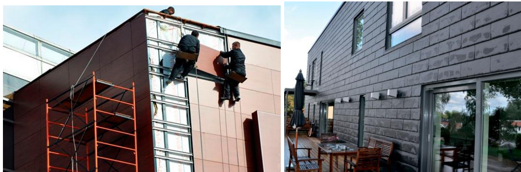
Рисунок 1 – Приклади будівель з вентиляльованими фасадами
