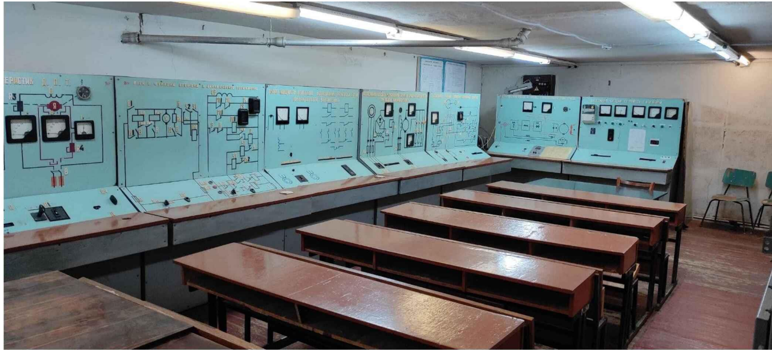
Лабораторія автоматизованого електроприводу
