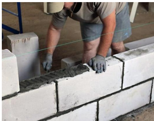
Рисунок 1 – Процес кладки стін із газобетонних блоків
