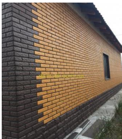
Рисунок 2 – Готовий вигляд фасаду оздобленого термопанелями.
