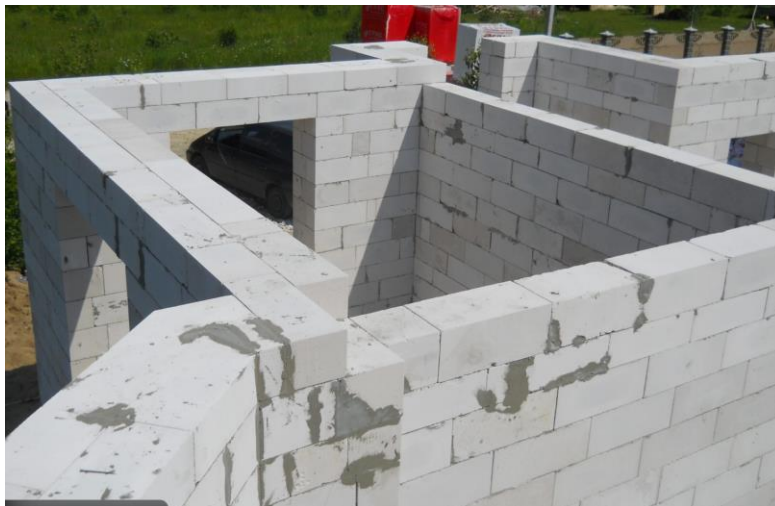
Рисунок 2 – Зовнішній вигляд стін із газобетонних блоків
